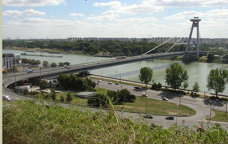
Obr. 7 Most SNP přes Dunaj v Bratislavě, vzadu sídliště Petržalka, pohled z bratislavského hradu
