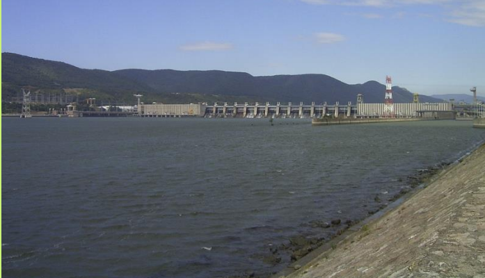
Obr. 21 Hydroelektrárna Železná vrata, v. 63 m, d. 1200 m, výkon 2100 MV
