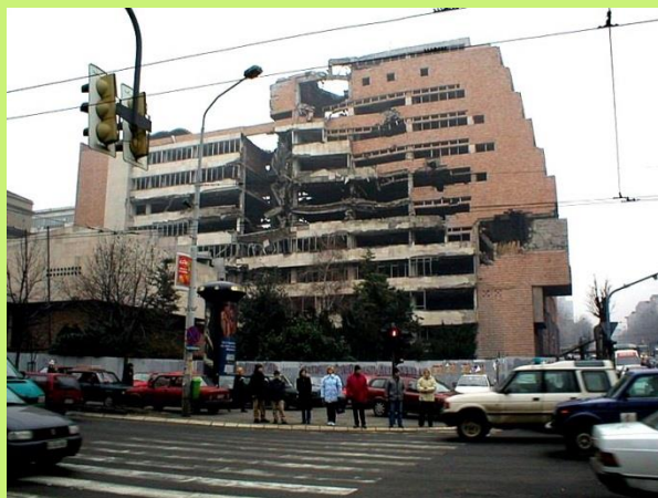
Obr. 37 Budova Ministerstva obrany v Bělehradě po náletech NATO, 1999
